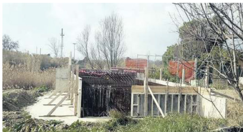
La costruzione del nuovo ponte ciclopedonale sul fiume Ete
