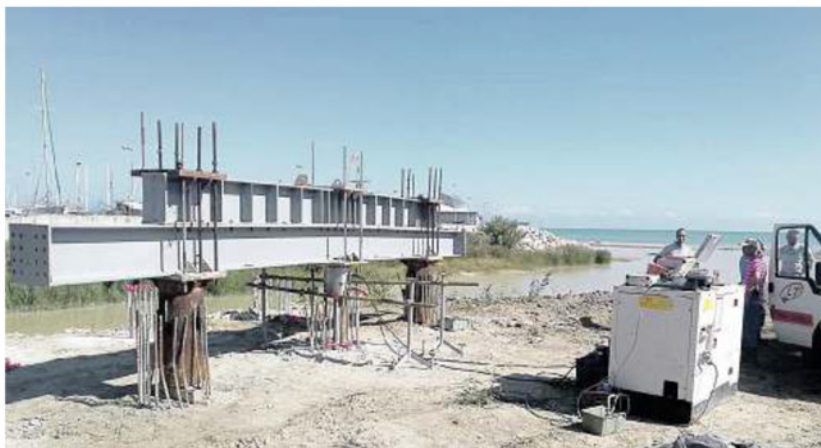
Il cantiere per la realizzazione del ponte ciclabile sul fiume Ete
